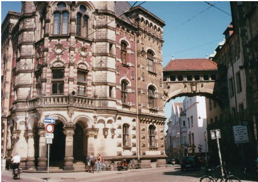
Bremen, Ostertorstraße 10: Gerichtsgebäude von 1895 (Foto: St., 27. 6. 2018 - vgl. die Fotos in Nr. 418 auf S. 3, 7, 11 und 15!)
