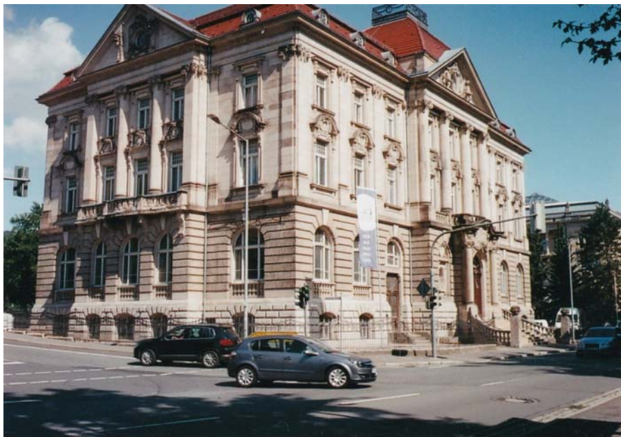
In Meiningen diente 1945 - 2001 als Gerichtsgebäude das 1909 erbaute Gebäude der „Bank für Thüringen“. (Foto: Steinberg, 13. Juli 2018)
