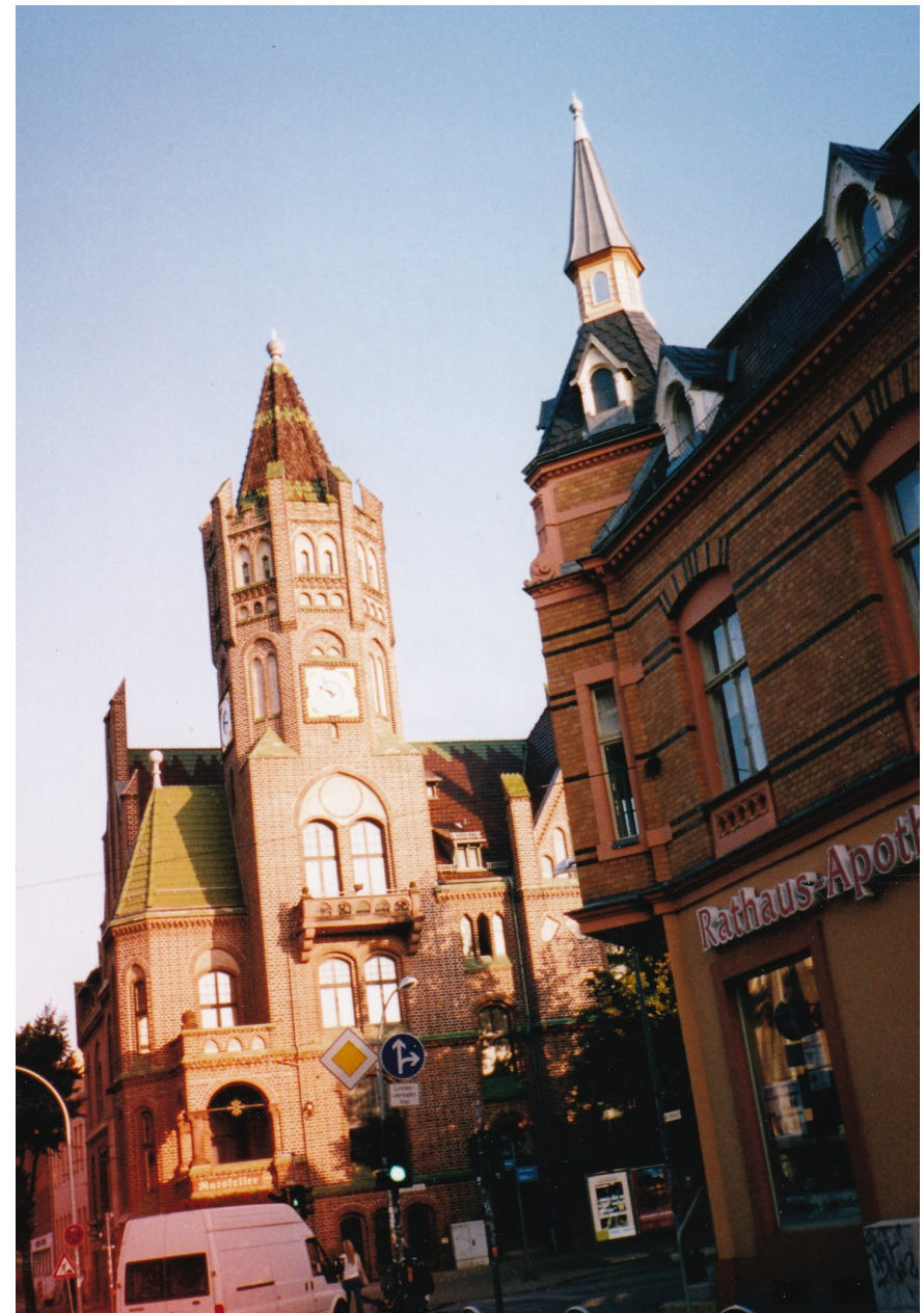
Das Rathaus von Nowawes (mit Ratskeller) (auch auf Seite 25) wurde 1898 aus Ziegelsteinen erbaut.
